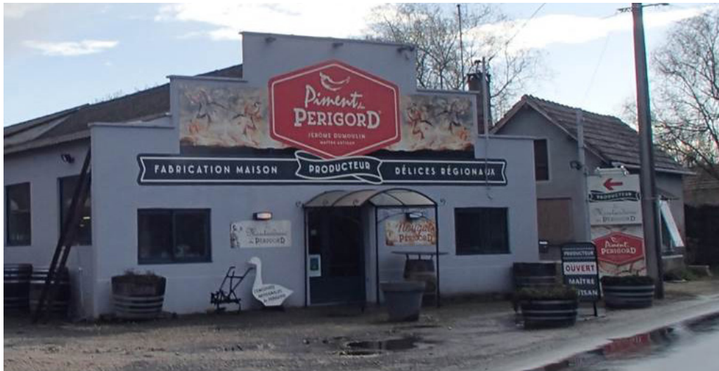
Surface cumulée des enseignes supérieure à 15 %
